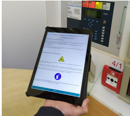
Die Unterweisung kann nun einfach und flexibel über das Tablet abgerufen und durchgearbeitet werden
