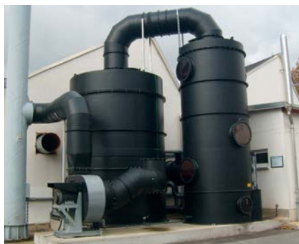
Biologische Abluftreinigungsanlage
